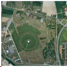
Juni Antennenanlage Gablingen bei Augsburg
