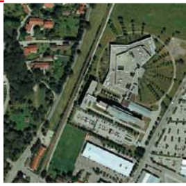
März Gewerbegebäude südlich von Erding
